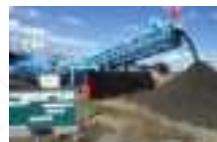
混合処理土排出
