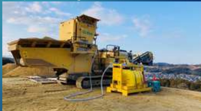
新名神高速道路 上田上新免工事
