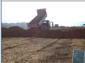
公共工事の盛土材
