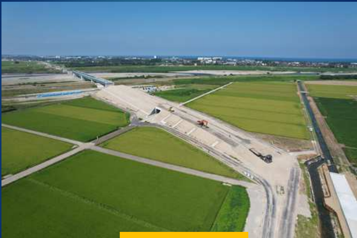
右岸盛土 施工状況
