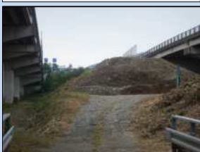
公共工事の建設発生土
