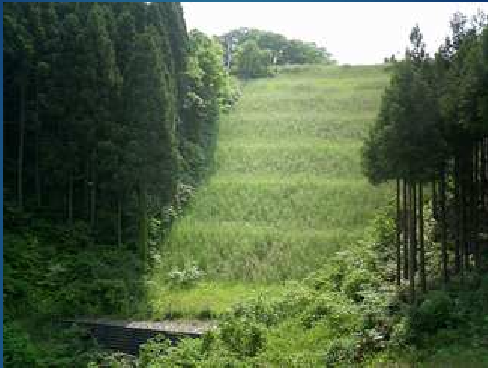
復旧後の状況
