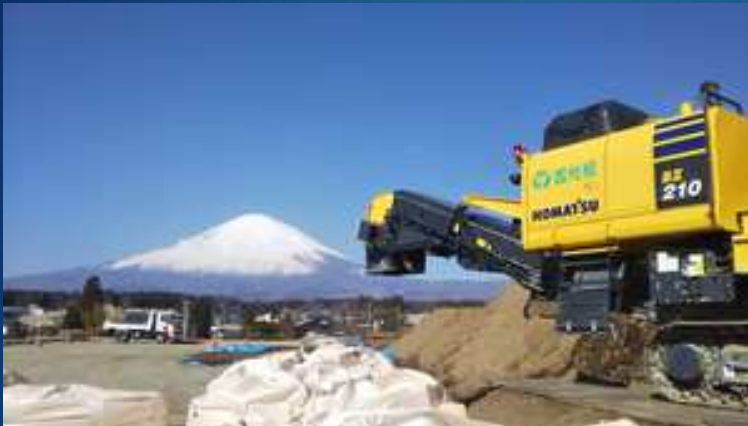
新東名高速道路 御殿場インターチェンジ工事
