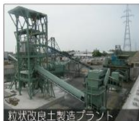
粒状改良土製造プラント
