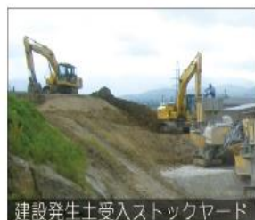
建設発生土受入ストックヤード
