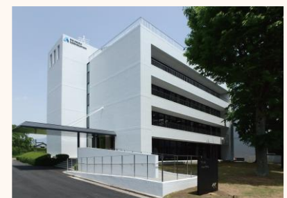
技術研究所 管理棟
