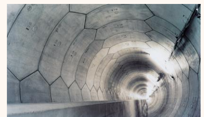
シールドトンネル (ハニカムセグメント使用)
