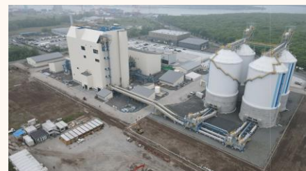
バイオマス発電所（北海道石狩市）
