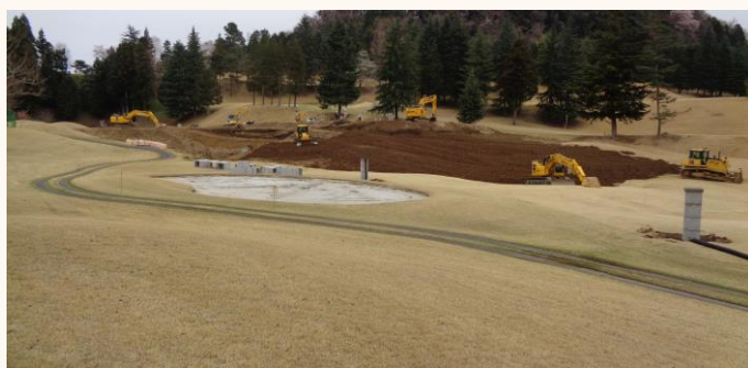
▲ ゴルフコース改良工事例
