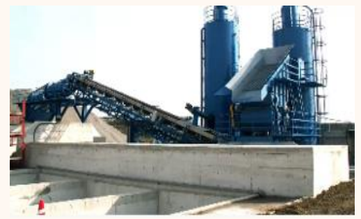
▲平成21年 造粒固化施設設置 (広島県福山市大門野々浜沖浦山 7482-1)
