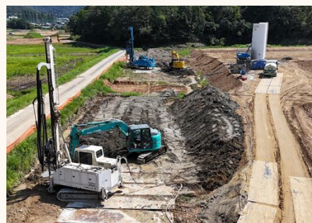
▲地盤補強（柱状改良）
