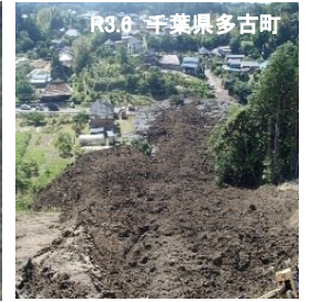
廃棄された土石の崩落 軽傷者1名、県道通行止め R3.6 千葉県多古町
